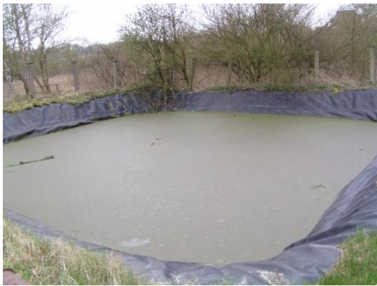
Abb. 1: Regenrückhaltebecken
