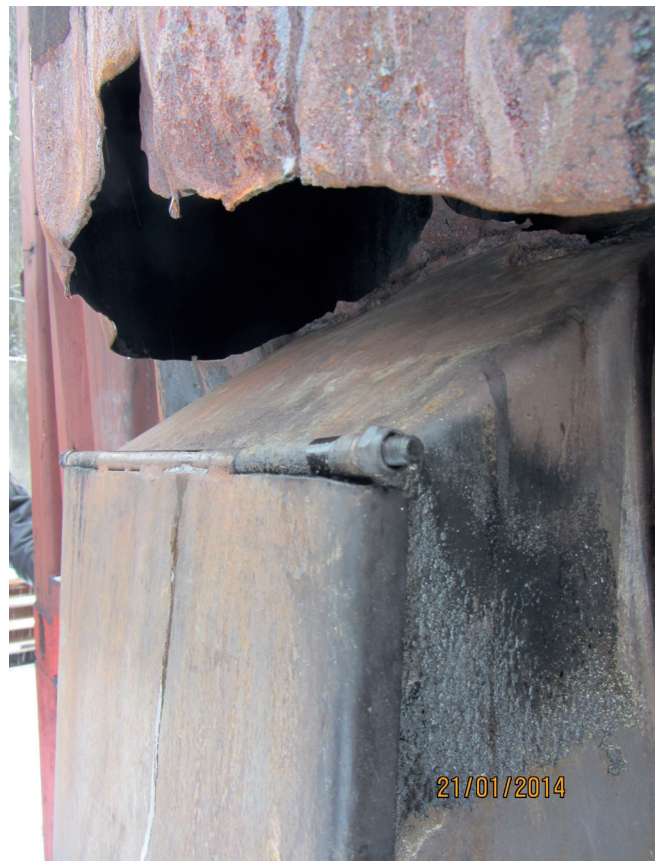
Bild 2: Druckentlastungsvorrichtung, außen
