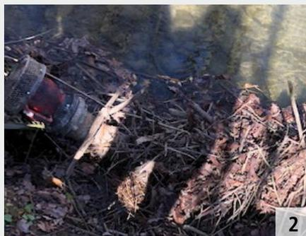
die zu bedenken sind. Diese Anlage ist gegen Diebstahl und Vandalismus ungeschützt. Des Weiteren können sich das gekrümmte Aufhängen des Saugschlauches und die Witterungseinflüsse negativ auf die Funktion auswirken. Das Material versprödet, die Saugleitung zieht Luft. Im Alarmfall kann dies dazu führen, dass die Saugstelle zunächst in Stand gesetzt werden muss, bevor Löschwasser entnommen werden kann. Dabei ergeben sich erhebliche Gefahren für die Feuerwehrangehörigen.
