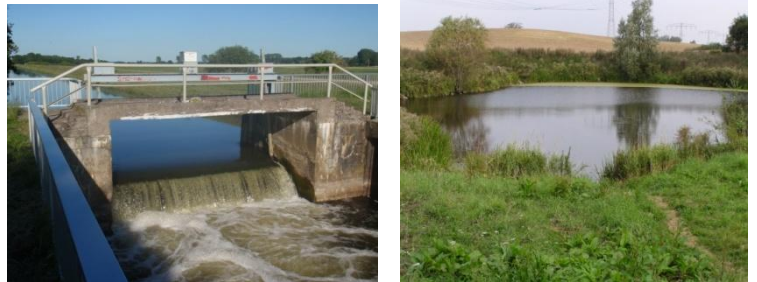
Abb. 8+9: Wehranlage und offenes Gewässer
