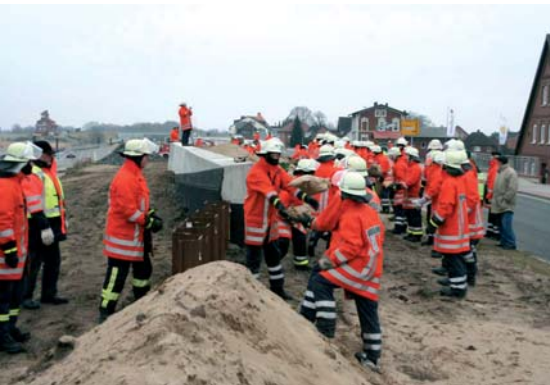
Einsatz zur Verstärkung des Deiches bei Hoopte.
