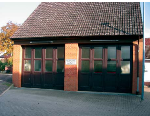
Ungünstig: Blendungen und Schlagschatten durch mittig über den Toren angebrachte Beleuchtung, wenn vor den Toren Fahrzeuge stehen.
