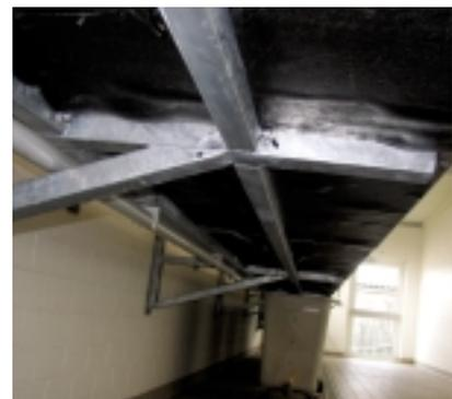
Lärmdämmung (schwarz) an der Unterseite des Schlauchtrogs.
