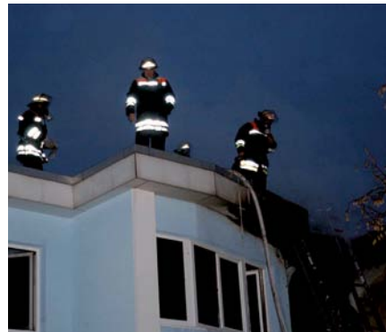
Absturzgefahr an der Kante des Flachdaches
