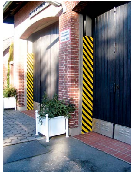
Gelb-schwarze Gefahrenkennzeichnung der Tordurchfahrt nach außen
