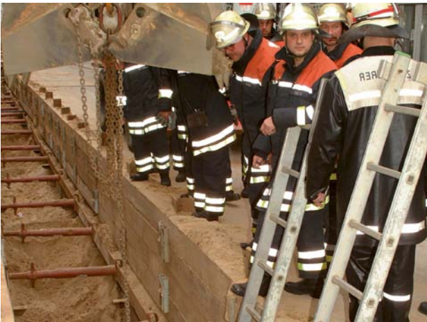
Leitern ermöglichen einen sicheren Zugang.
