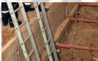
Sicherer Zugang in den Graben über Leitern
