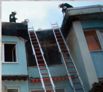
Absturzgefahr! Brandbekämpfung auf dem Flachdach
