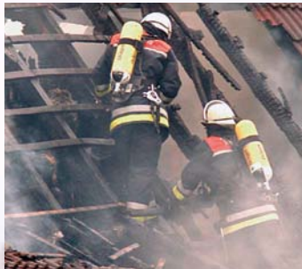
Durchbruchgefahr! Unsicherer Stand auf angebrannten Dachlatten
