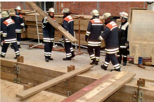
Behelfsmäßiger Übergang aus Bohlen
