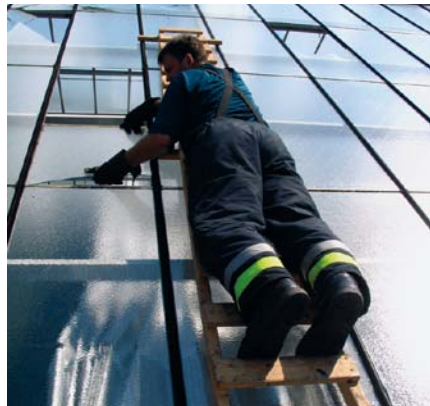
Beschädigte Glasscheiben eines Gewächshauses werden nach Beschädigung durch Hagelschlag vorsichtig entfernt (Feuerwehrlhelm und Schutzjacke wurden auf Grund großer Hitze abgelegt).
