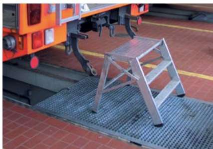
Das Abdecken nicht benutzter Teile von Arbeitsgruben ist immer die sicherste Lösung.
