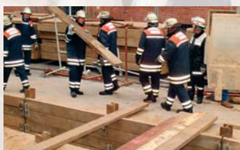
Behelfsmäßig hergestellter Über- gang aus Bohlen
