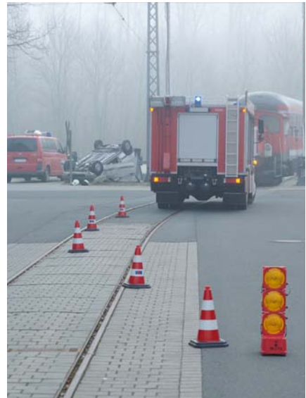
Sperrung einer Fahrspur mit Verkehrsleitkegeln und Warnleuchten
