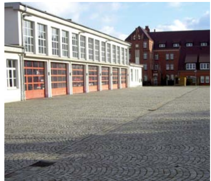
Der Stauraum vor den Toren bringt Sicherheit.
