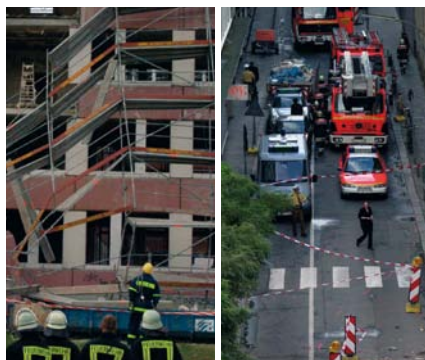
Der Gefahrenbereich ist auch für Einsatzkräfte abgesperrt.
